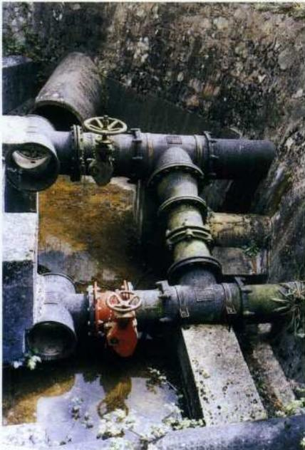
*Lors d'une intervention sur un siphon, il importe de pouvoir le vidanger d'où la mise en place de vannes d'évacuation et d'exutoires situés au point bas de la conduite.*
