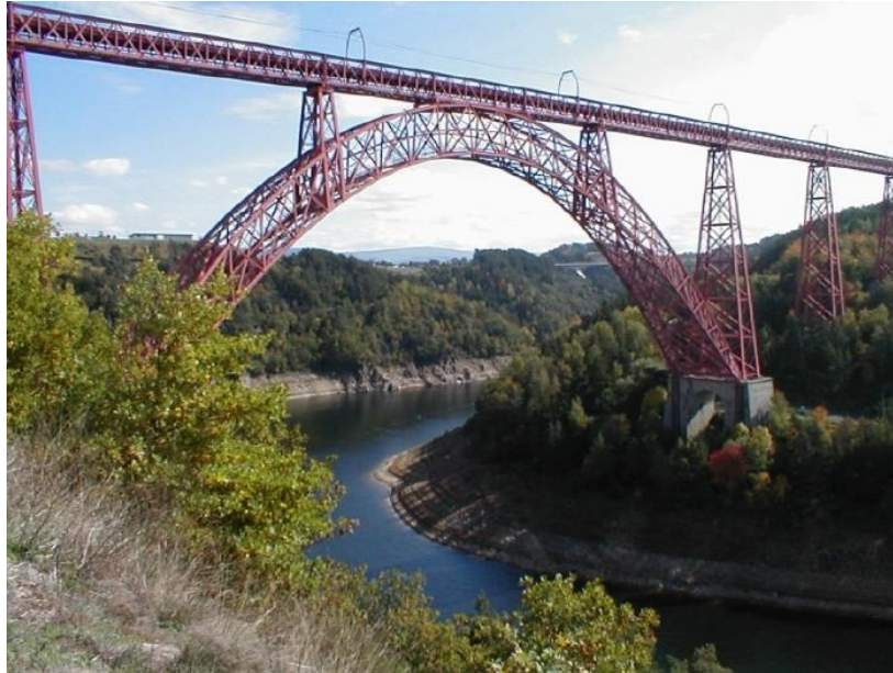
viaduc de Garabit
